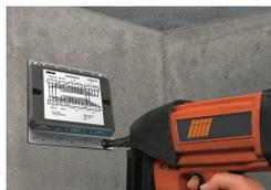
Fissaggio della piastra di montaggio con la scatola di distribuzione WINSTA® alla parete (ad es. mediante pistola chiodatrice).
