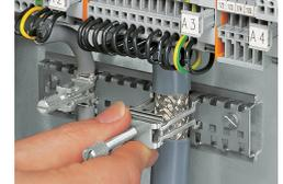
Supporto con piede di fissaggio\* (790-113), lunghezza 45 mm, barra collettrice a 90° rispetto alla guida DIN
