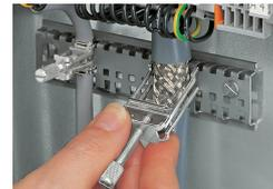
Serraggio/rimozione di un morsetto per cavi schermati.
