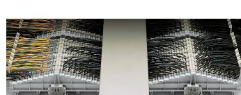
Esempio di assemblaggio di matrice di ripartizione
