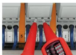
Test di funzionamento tramite prese per test protette dal contatto accidentale
