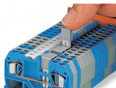
Collegamento a ponte impiegando un ponticello orizzontale (280-402).
