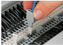
Test con una spina di prova.
