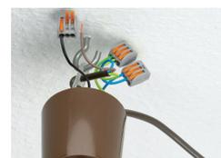
Connessioni fisse per illuminazione con conduttori flessibili e alimentazione di potenza
