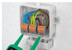
Test tramite Profi-LED+ tester indicatore di tensione (206-806).
