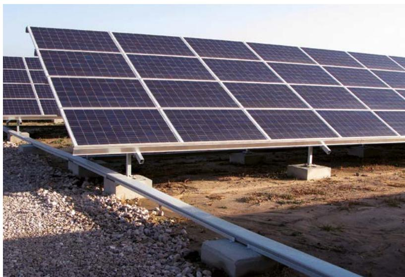
Il sistema di passerelle isolanti Unex è progettato tenendo conto dell'assorbimento delle dilatazioni termiche.
