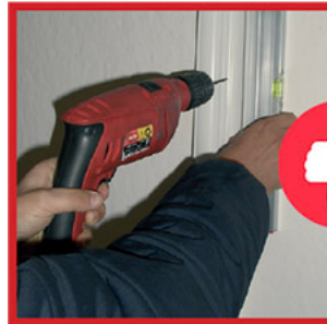
Installazione canalina senza bolla incorporata
