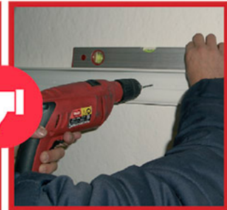
Installazione canalina senza bolla incorporata
