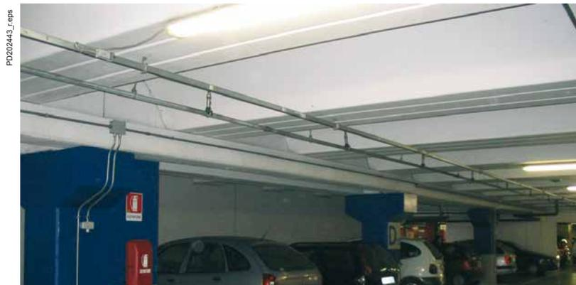
Condotti sbarre Canalys KBA con lampade e sprinkler.
