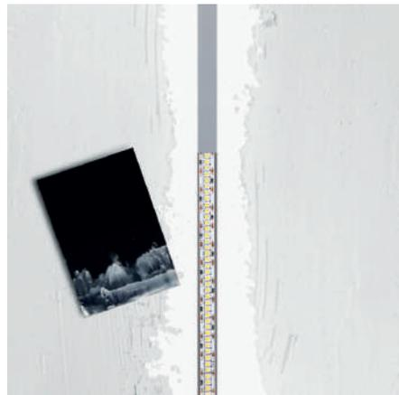
Una volta fissato, rasare per ottenere una superficie liscia. La zona di rasatura distante dall'alloggiamento della strip LED rende più sicuro e facile questo passaggio.
