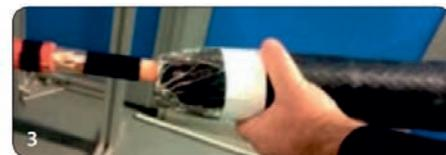
Posizionato al centro della connessione e fatto collapsare sul cavo rimuovendo il supporto interno
