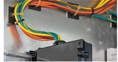
8. Acheminer les fils de détection et le câble système de sorte à éviter les bords coupants, les points de coincement ou toute autre source pouvant entraîner des dommages mécaniques.
