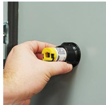
3. Serrer l'écrou du panneau jusqu'à ce que l'écrou et la rondelle d'étanchéité soient en contact complet avec la surface de l'enceinte. Ensuite, serrer l'écrou d'un quart de tour supplémentaire. Serrer l'écrou du panneau à la main uniquement. Ne pas trop serrer.
