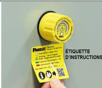
9. Apposer l'étiquette d'instructions à l'extérieur de l'enceinte directement sous le module d'indication ou à côté de ce dernier (voir Remarque 1). Indiquer sur l'étiquette où le VAT est installé dans le circuit.
