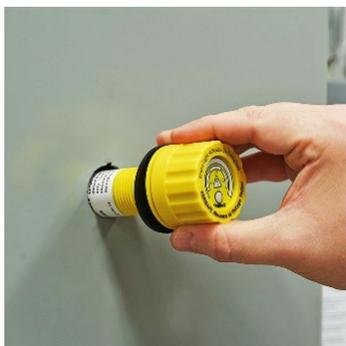
1. Insérer le module d'indication dans le trou de 30 mm de l'ouverture défonçable, tout en alignant l'encoche anti-rotation. S'assurer que la rondelle en caoutchouc est placée à l'extérieur de l'enveloppe.
