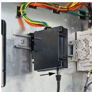
6. Insérer l'autre extrémité du câble système dans le connecteur au bas du module d'isolement.
