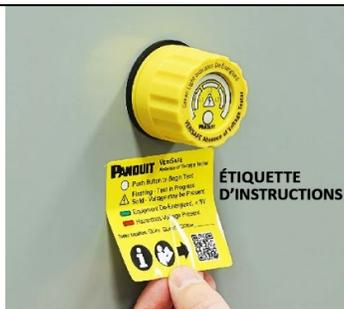
9. Apposer l'étiquette d'instructions à l'extérieur de l'enveloppe directement sous le module d'indication ou à côté de ce dernier (voir Remarque 1). Indiquer sur l'étiquette où le VAT est installé dans le circuit.
