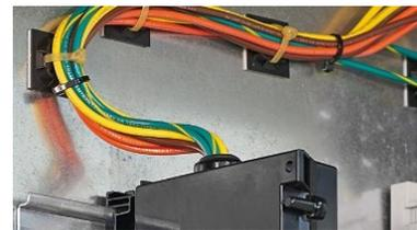
8. Acheminer les fils de détection et le câble système de sorte à éviter les bords coupants, les points de coincement ou toute autre source pouvant entraîner des dommages mécaniques.
