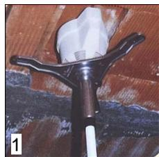
TRAMITE 3 TASSELLI PROVVISORI NELLE APPOSITE ASOLE, OPPURE CON UN APERTICA A MOLLA IN USO AI MURATORI, APPOGGIARE IL TUTTO AL SOFFITTO GREZZO E MANTENERE COSÌ POSIZIONATA LA SCATOLA (FIG.1); LA CONFIGURAZIONE DEL SISTEMA PERMETTE DI POSIZIONARE PRECISAMENTE LA SCATOLA AD 1CM ESATTO DAL LATERIZIO, LASCIANDO COSÌ LO SPAZIO PER IL SUCCESSIVO INTONACO. E' AGEVOLE L'USO CONTEMPORANEO DI PIÙ APPLICATORI (FIG.2).
