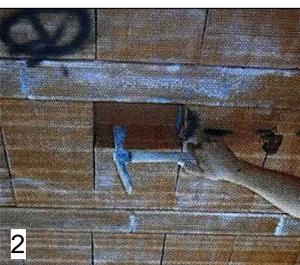
POSIZIONARE I FARETTI DURANTE LA FASE DI TRACCIATURA DELL'IMPIANTO ELETTRICO, PER QUANTO POSSIBILE, AL CENTRO DEL LATERIZIO (FIG.1). FORARE IL SOFFITTO, IL PIÙ PRECISAMENTE POSSIBILE PER NON COMPLICARE SUCCESSIVE OPERAZIONI DI STUCCATURA, NEI PUNTI DESIDERATI PER IL FISSAGGIO DELLE CONTROCASSE E IL PASSAGGIO DEI CURROGATI (FIG.2).
