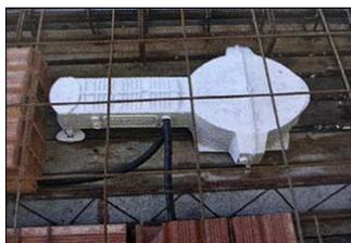
APRIRE IL FORO D'INGRESSO (DA NON DIMENTICARE) DEL TUBO CORRUGATO DI ALIMENTAZIONE ED INSERIRE LO STESSO POSIZIONANDOLO IN MODO TALE CHE SIA BEN FERMO, ANCHE LEGANDOLO AI FERRI DI ARMATURA.
