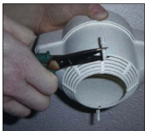
TAGLIARE COMPLETAMENTE I PIEDINI D'APPOGGIO DELLA SCATOLA NON NECESSARIO IN QUESTA TIPOLOGIA DI INSTALLAZIONE.
