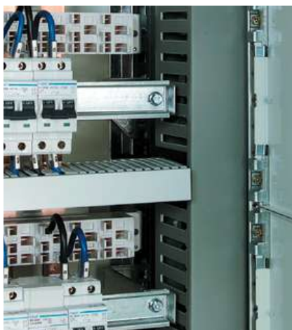
▲ fissaggio delle canaline orizzontali e verticali con supporto ad innesto
