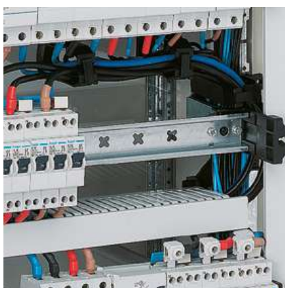
▲ fissaggio dei cinturini guidafili con supporti ad innesto
