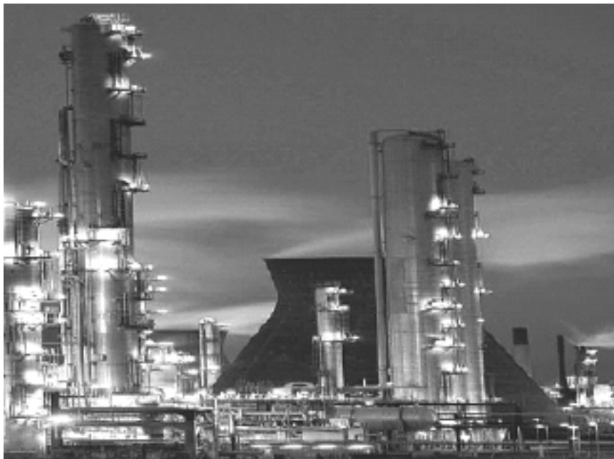
Impianto per la raffinazione delle materie plastiche
