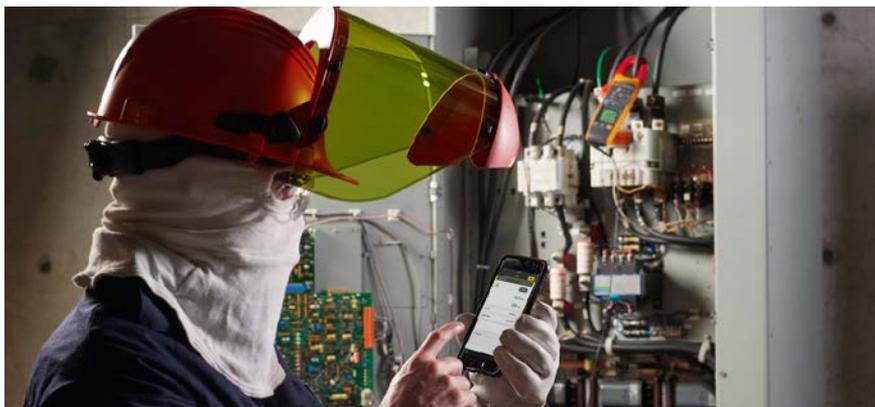
Fluke Connect consente di inviare le misurazioni a uno smartphone per la registrazione, la collaborazione e l'analisi.
