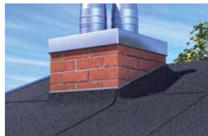
Sigillatura intorno a tetti con guaine bituminose
