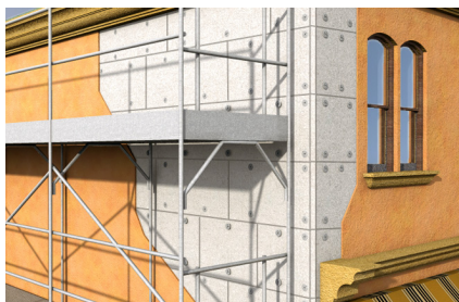
Fissaggio di pannelli isolanti
