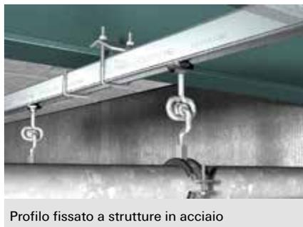
Profilo fissato a strutture in acciaio
