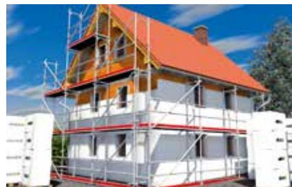
Pannelli di isolamento resistenti a compressione
