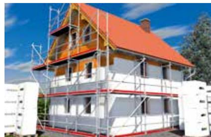
Pannelli di isolamento resistenti a compressione
