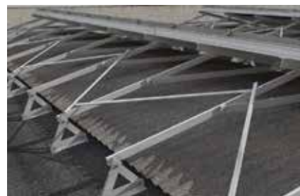
Dettaglio: fissaggio controvento
