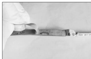
Figura 1. Rimuovere la pellicola protettiva dal nastro biadesivo
