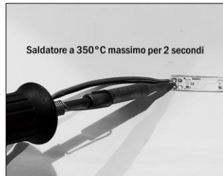
Figura 4. Saldatura dei cavi. Utilizzare stagno senza piombo
