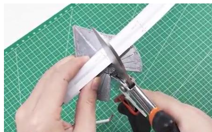
1. Tagliare la striscia LED nella misura desiderata rispettando sempre i segni tratteggiati riportati sulla guaina esterna. La serie 18/67520-00 può essere sezionata ogni 5 cm. Assicurarsi di effettuare un taglio netto.
