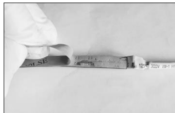
Figura 1. Rimuovere la pellicola protettiva dal nastro biadesivo
