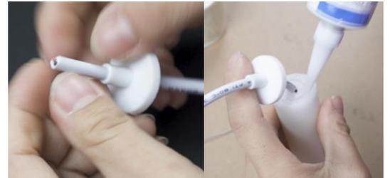
6. Inserire il tappo di chiusura facendolo passare attraverso il cavo di alimentazione tramite l'apposito foro. Applicare abbondante silicone in prossimità dell'estremità del tubo dove andrà appoggiato il tappo di chiusura. Il silicone in eccesso dovrà fuoriuscire durante la pressione del tappo sul tubo.
