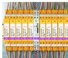
2x 165 etichette autoadesive per la marcatura dell'indirizzo bus degli apparecchi di controllo DRC MCM XT (BA1 fino a BA15) e la numerazione progressiva degli elementi base o moduli di protezione BXT (1.1-1.10 fino a 15.1-15.10).
