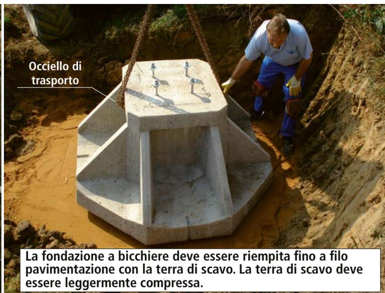
La fondazione a bicchiere deve essere riempita fino a filo pavimentazione con la terra di scavo. La terra di scavo deve essere leggermente compressa.
