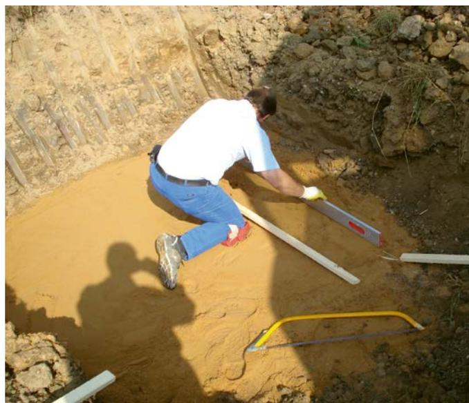
Fig. 3a Scavo di fondazione con letto di sabbia
