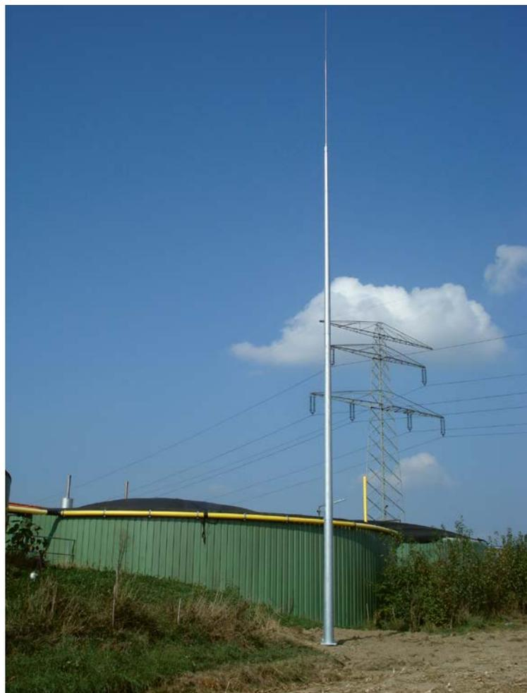
Fig. 2 Impianto biogas con palo di captazione componibile
