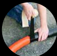
Riparazione di danni di maggiore entità delle guaine dei cavi
