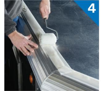
**Pressare** il nastro con un rullo morbido per conformarlo ai bordi delle giunzioni o altri elementi sporgenti.
